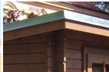
oplechování pultové střechy
