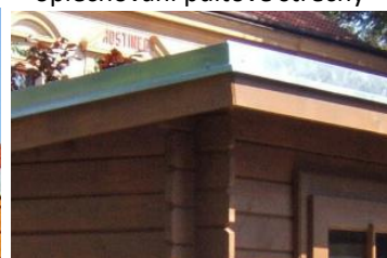
oplechování pultové střechy
