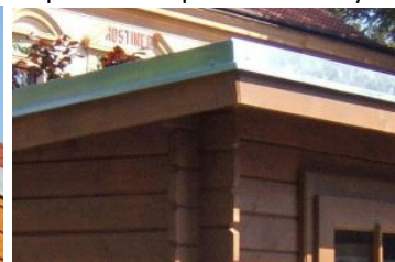
oplechování pultové střechy
