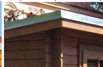
oplechování pultové střechy
