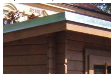
oplechování pultové střechy
